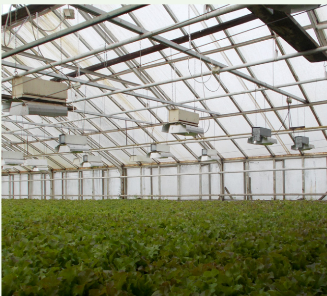
Gaismas trūkumu kompensē ar augstspiediena nātrija spuldzēm (400 W)
