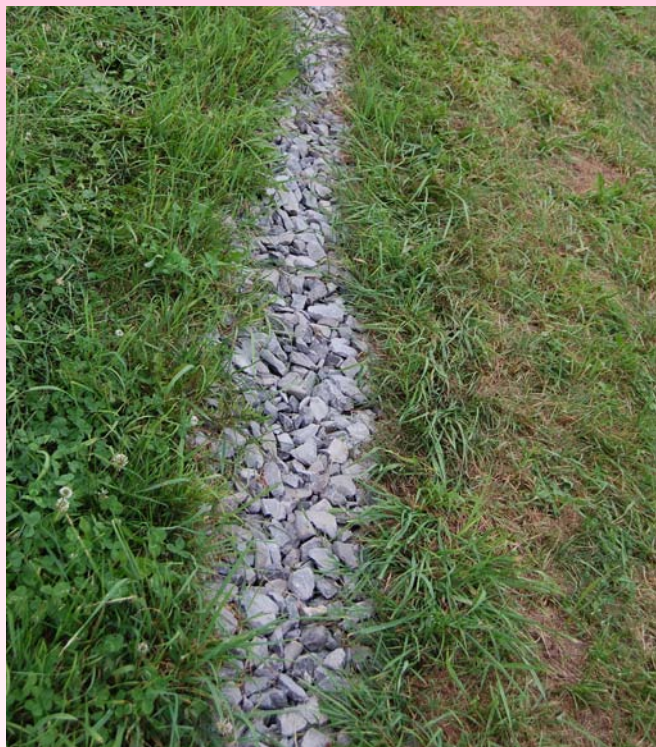
Viens no vienkāršākajiem lauka meliorēšanas pasākumiem ir grāvju veidošana.
